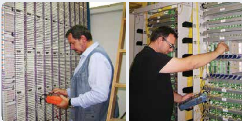
Mario Leonard Rebuš obavlja mjerenje na bakrenom razdjelniku (lijevo), a Josip Antolović na optičkoj mreži (desno)
