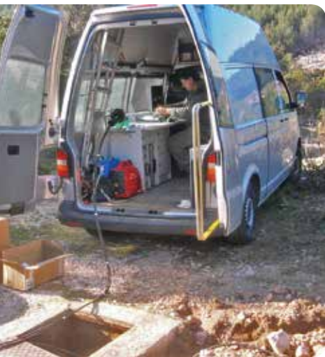
Radovi na spajanju svjetlovodnog kabela
