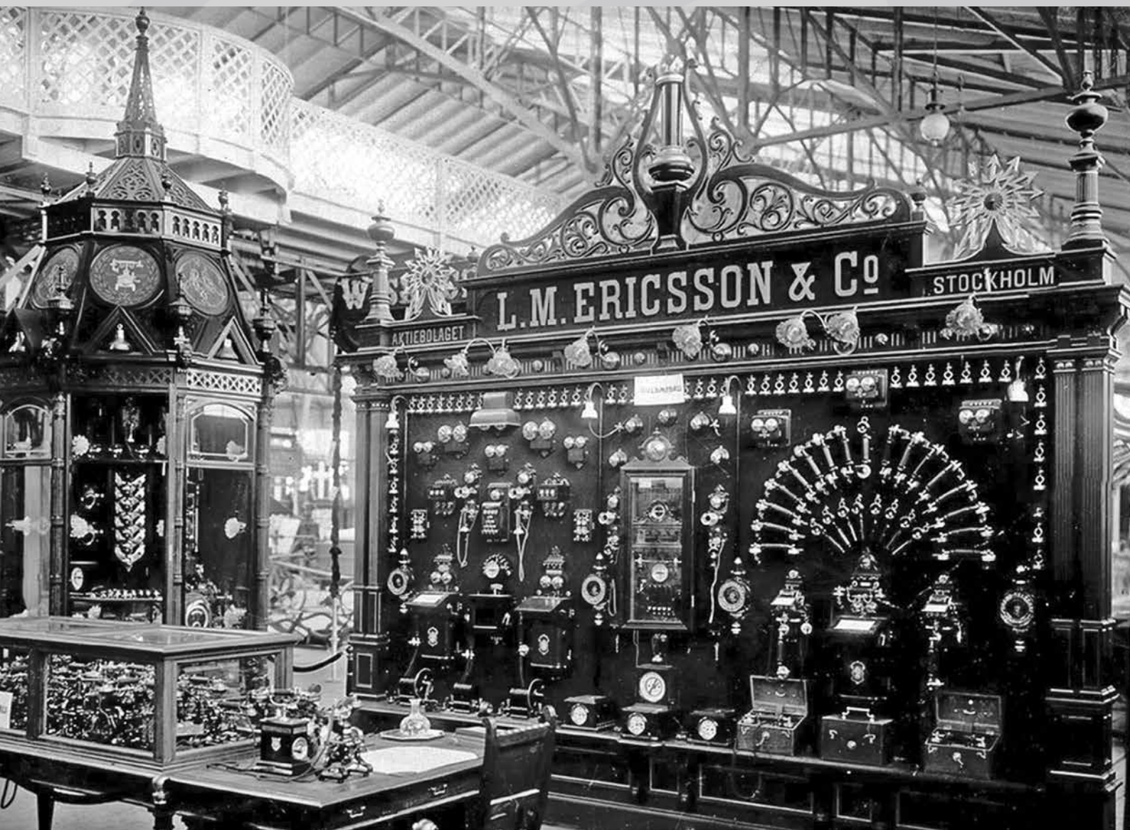
Raskoš Ericssonovih telekomunikacijskih rješenja s kraja 19. stoljeća, (fotografija iz arhive korporacije Ericsson)
