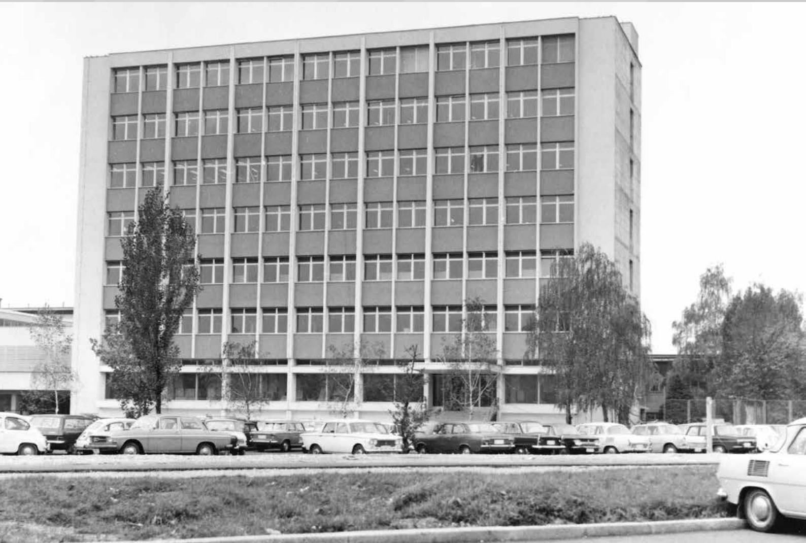
Južno krilo poslovne zgrade „Nikole Tesle“ izgrađeno je početkom sedamdesetih godina
