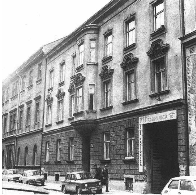
Zgrada u Palmotićevoj 82 u kojoj su postavljeni temelji današnjeg Ericssona Nikole Tesle
