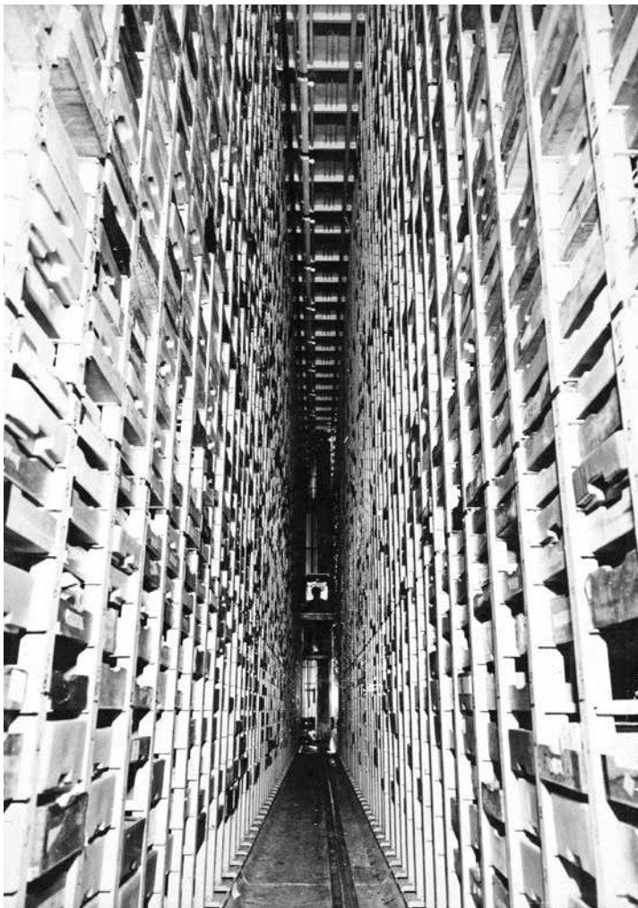
Visoko regalno skladište
