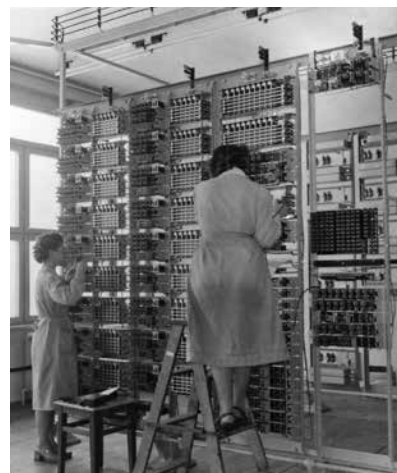
Montaža crossbara , 1955. godina
