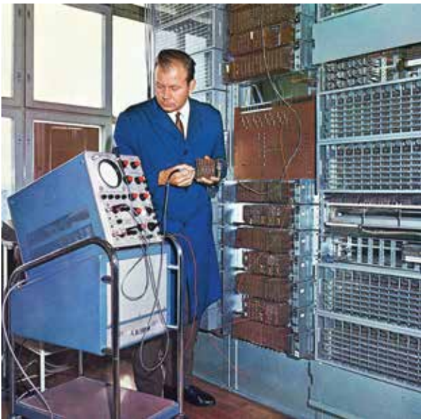
Gore: Crossbar - montaža stalaka
