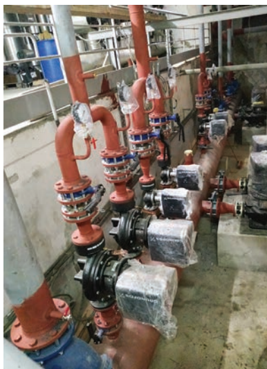
Radovi na glavnoj toplinsko-izmjenjivačkoj stanici
